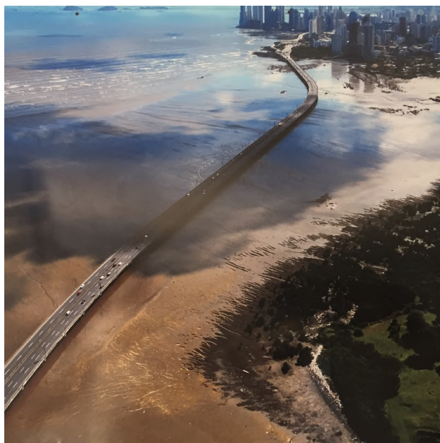
Diseño e interventoría de la reparación estructural del viaducto marino de circunvalación de la Ciudad de Panamá.
