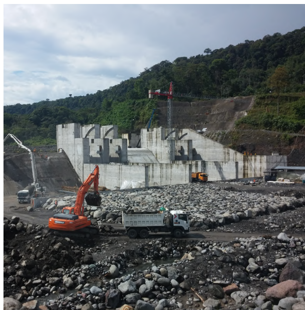
Interventoría de la Construcción de la Presa y Central Hidroeléctrica del Río Dué, en Ecuador.
